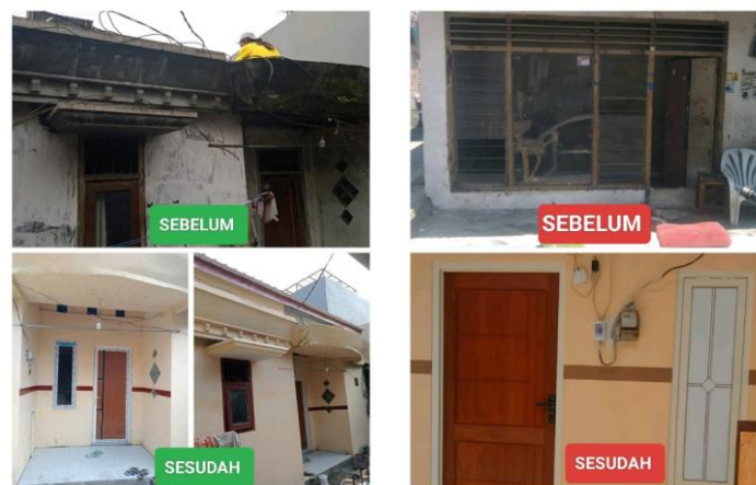
Gambar 1. Kondisi rumah sebelum dan sesudah rehabilitasi melalui Program Dandan Omah di Kelurahan Kendangsari
